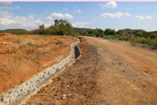
施工后道路旁排水渠
