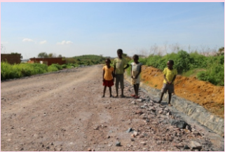
平整过的道路
