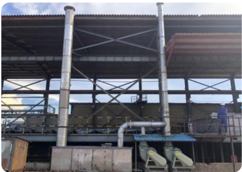
酸雾风机安装完成
