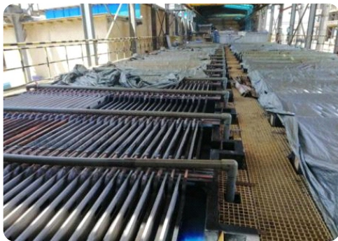
酸气回收管路安装完成
