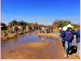
施工前房屋进水及道路积水
