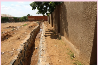
施工后道路旁排水渠
