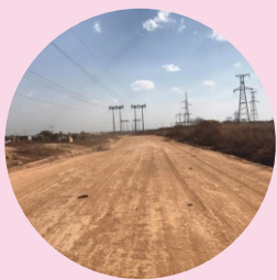
CDM为KASAPA修整过的道路
